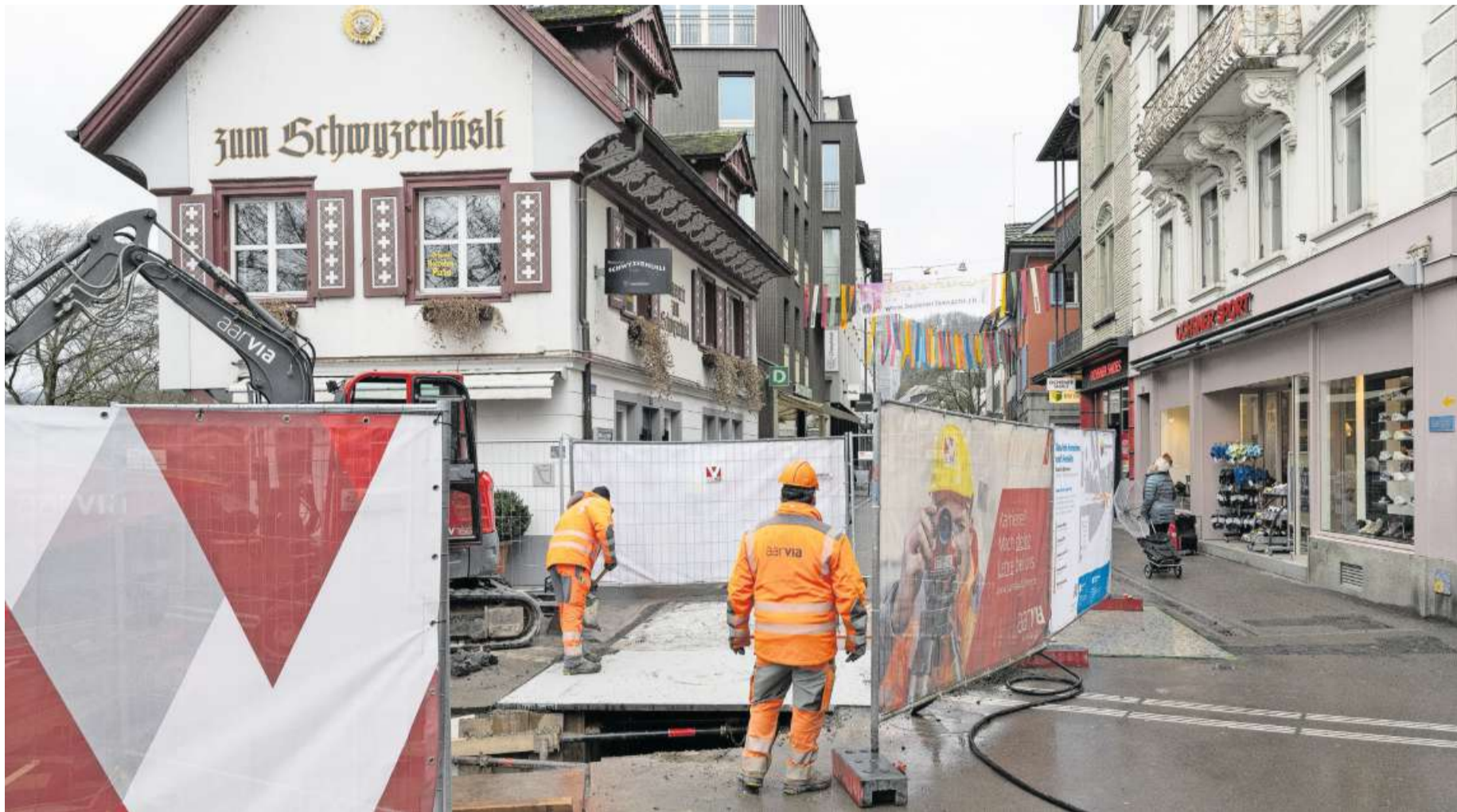
Baustelle auf dem Unteren Bahnhofplatz Anfang Badstrasse: An vielen Stellen der Stadt werden Leitungen für das Fernwärme- und Fernkältenetz verlegt.
