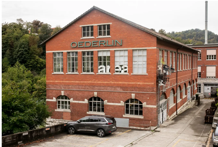
Blick auf einen Teil des Oederlin-Areals.
