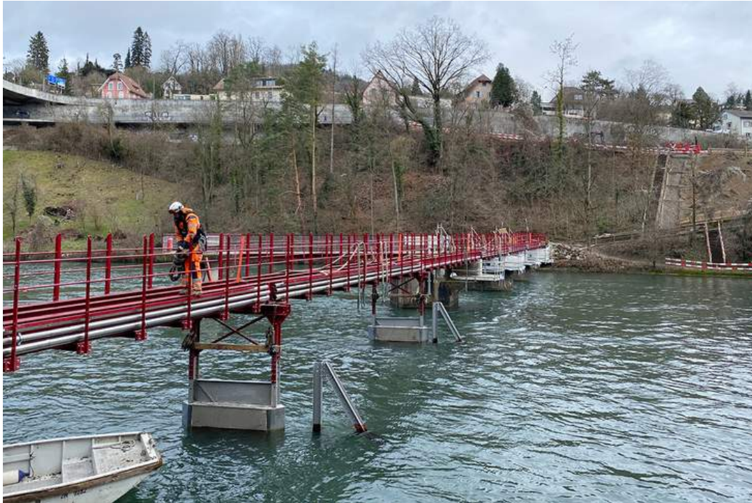
Die tonnenschweren Elemente des Limmatstegs werden montiert
