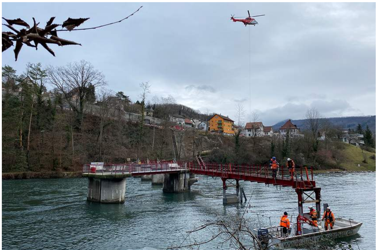
Der Helikopter fliegt die ertüchtigten Brückenteile heran (Bilder: zVg)
