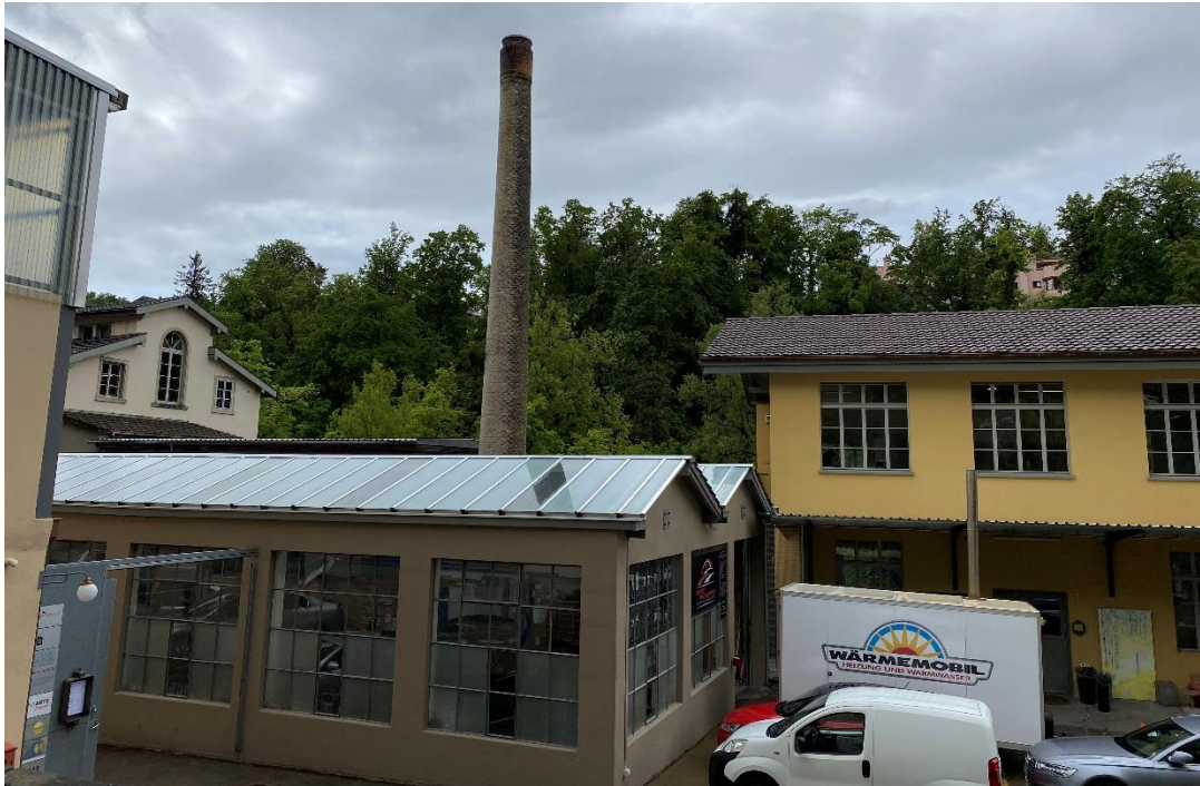
Das Oederlin Areal befindet sich in den Gemeinden Ennetbaden und Rieden bei Baden.
