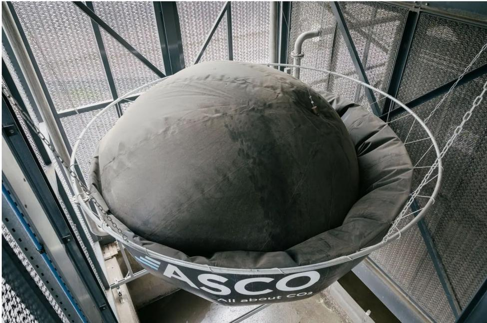
Über einen Ballon wird das gasförmige CO<sub>2</sub> in die neue Anlage gepumpt.
