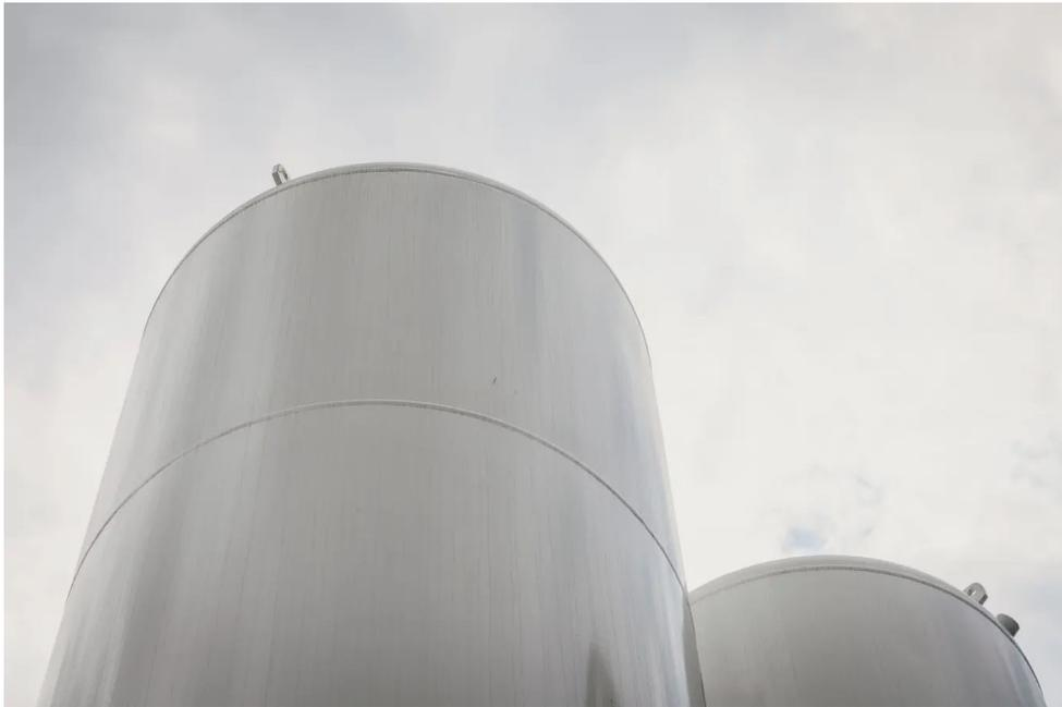
Die beiden CO<sub>2</sub>-Lagertanks ragen 12 Meter hoch in den Himmel. Sie sind ein wichtiger Bestandteil des Verflüssigungsprozesses.
