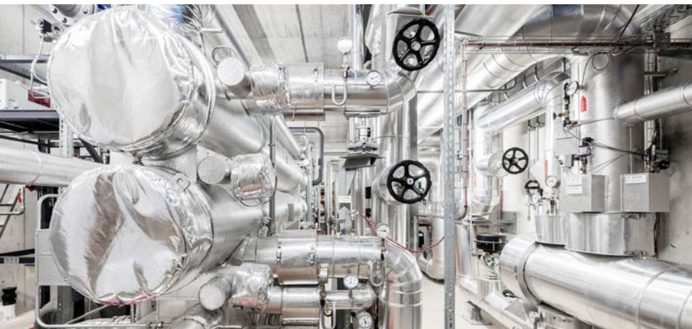
Einblick ins Kesselhaus während des Umbaus
