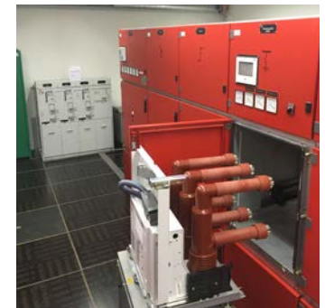
Pol-Erdungsschalter mit Schutz- und Steuergerät
